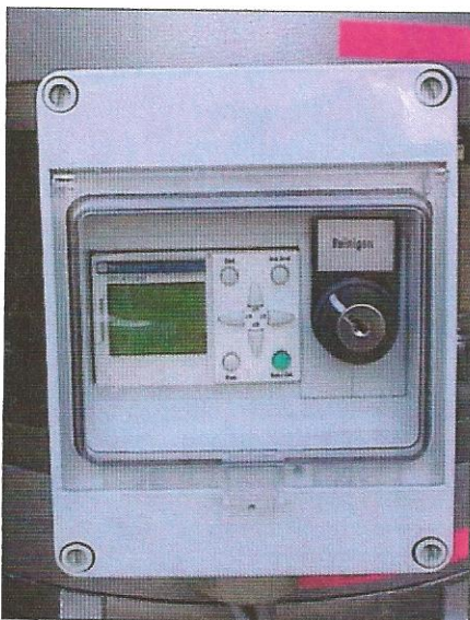
Abb. 5: Steuermodul mit Schlüssel-Schalter für Funktion 'Reinigung'
